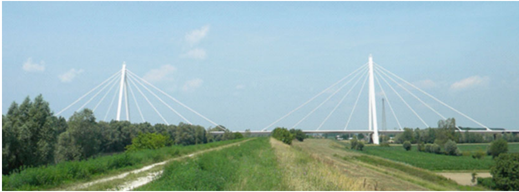
Fig. 17.1 Overview of the 'Ponte sull'Adige' bridge
